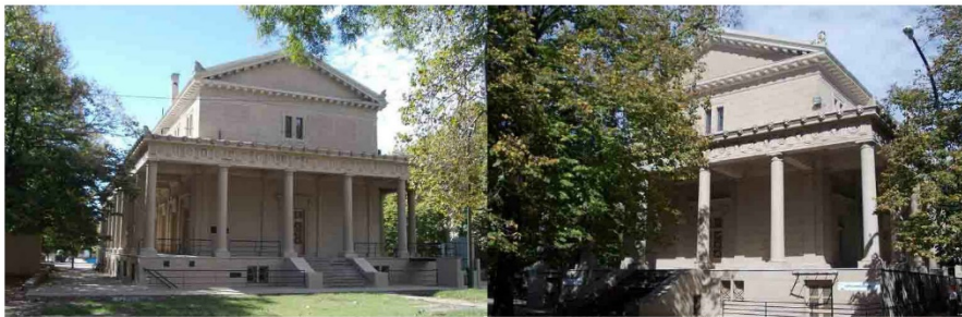
Fotografías de la situación actual. Fachada NE
