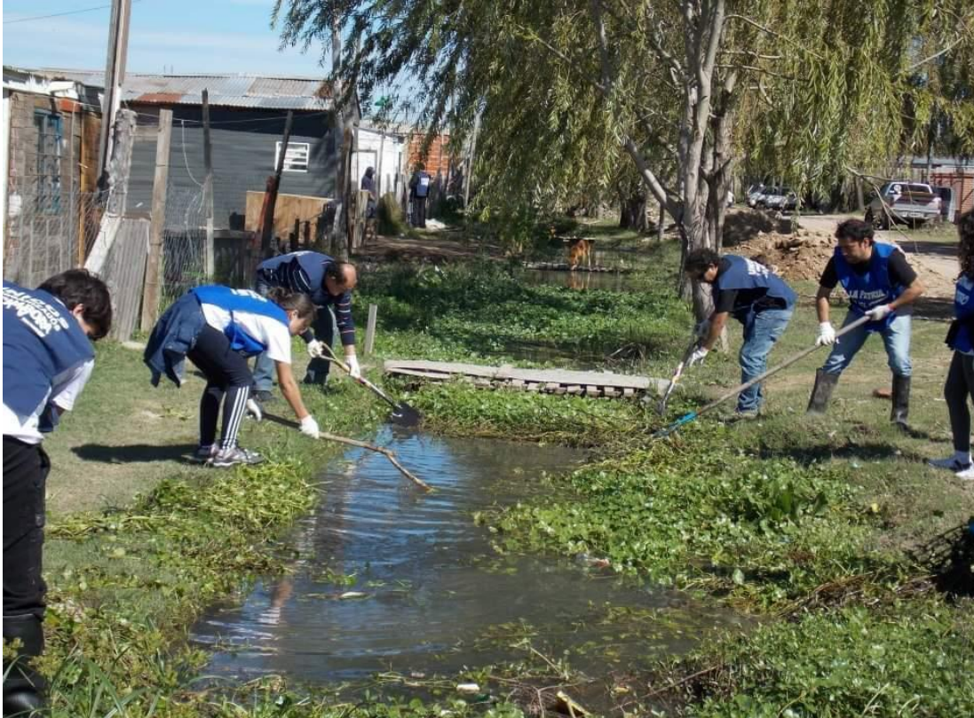
Militantes y voluntarias limpiando las zanjas que fueron afectadas tras el temporal.
