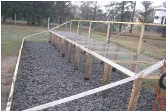
Fig. 2. Vista de la estructura del tendalero modificada
