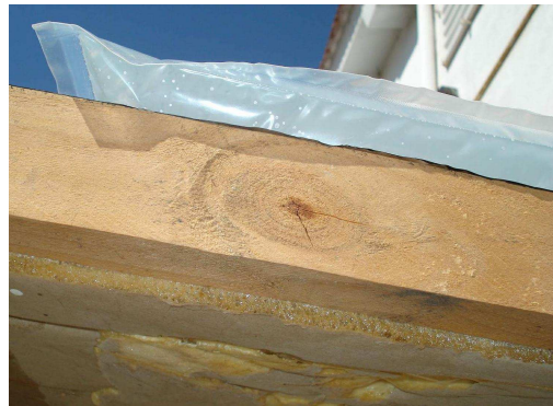
Figura 5: Aislación de poliuretano y marco de madera.
