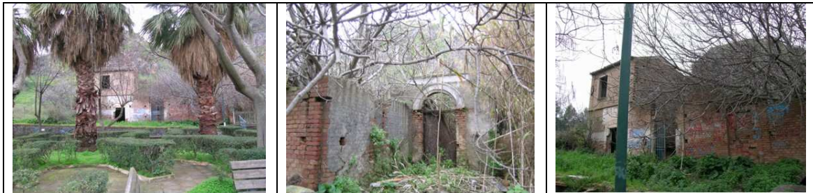
Figura 29: Fotos de relevamiento de la situación actual ex baños termales.
