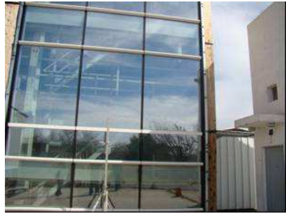
Foto 2: Vista de la fachada vidriada bajo ensayo.
