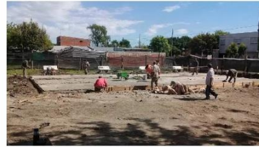
La Placita de 29 y 89 en construcción.
