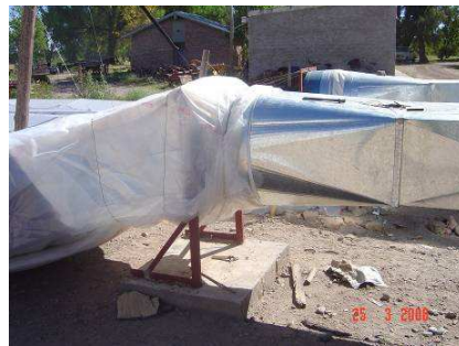
Figura 5: Ventilador entre colector y ducto
