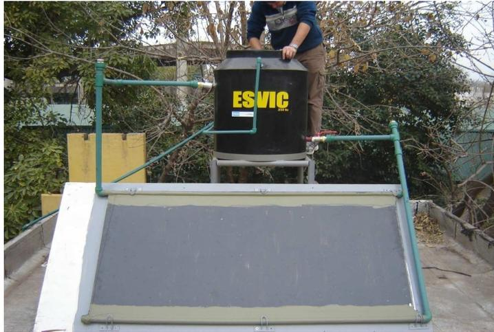
*Figura 5 - En la figura puede observarse como queda montado el panel sobre su bastidor y como se conecta al tanque de almacenamiento*
