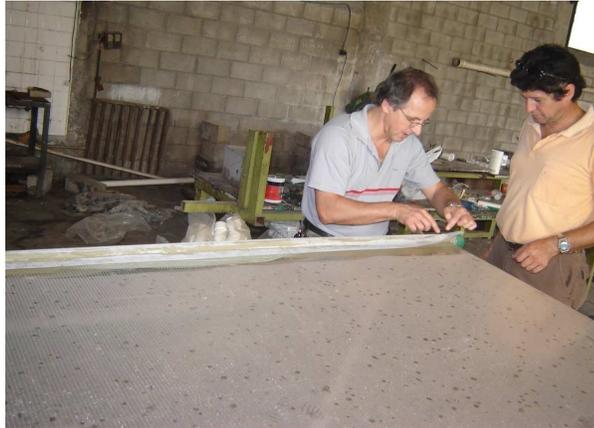
*Figura 3 - Recubriendo la unión del caño ranurado y la plancha de policarbonato con manta y pintura asfáltica. La intención es de sellado y protección*
