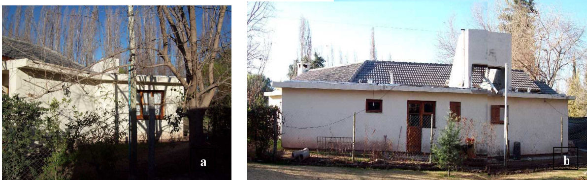
Figura 4: a) vista del frente (muro SO y O) y b) vista de la fachada S del edificio.
