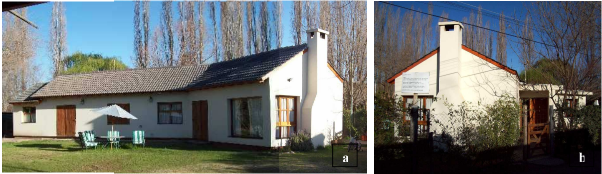
Figura 3: a) se puede observar la fachada N de la vivienda y la fachada NE y NO del estar y b) fachada NO.
