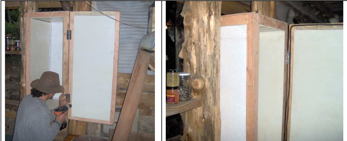
Figura 1a): Se observa el interior sellado y pintado. La cara interna posterior es de chapa.
