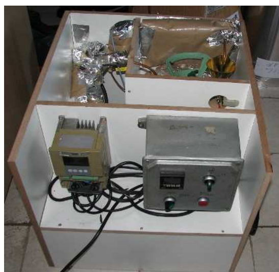
Figura 7: Montaje del sistema sin la tapa superior de la estructura de montaje
