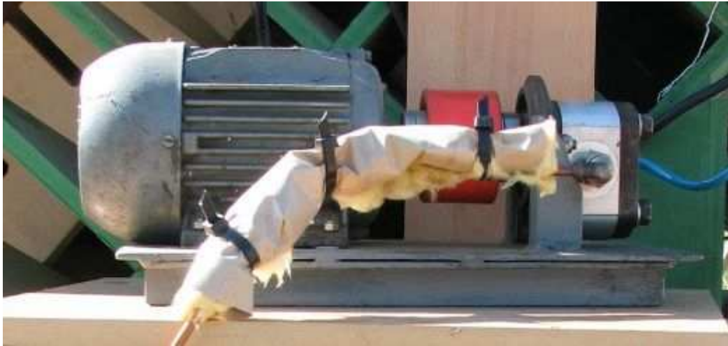
Figura 3: Motor y bomba hidráulica
