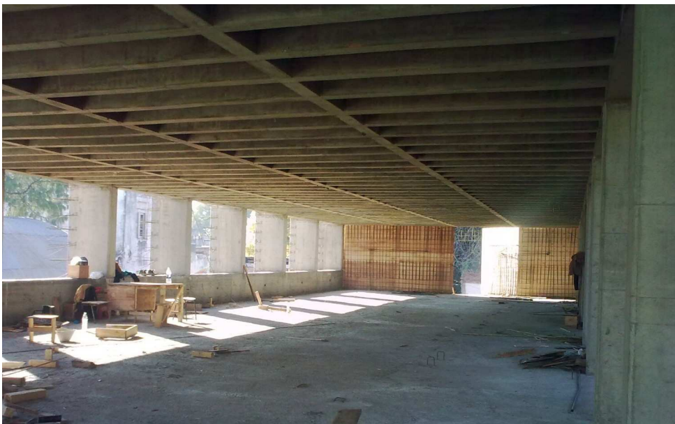
Figura 11: Vista interior del bloque en el primer piso (Diseño de Interiores) y sistema envigado de entrepisos
