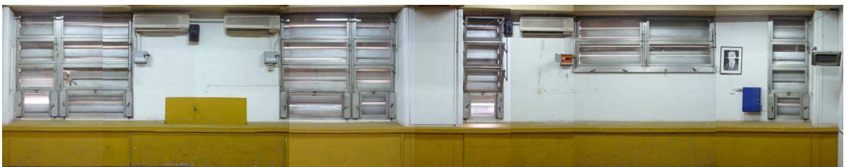
Figura 4: Vista interior del aula con el aventanamiento actual.
