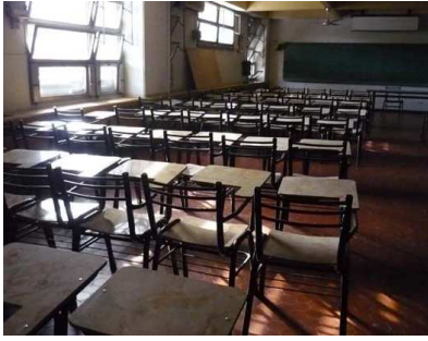
Figura 12: Vista interior del aula: se observa ingreso de radiación solar (21 junio - 10:00 hs.)
