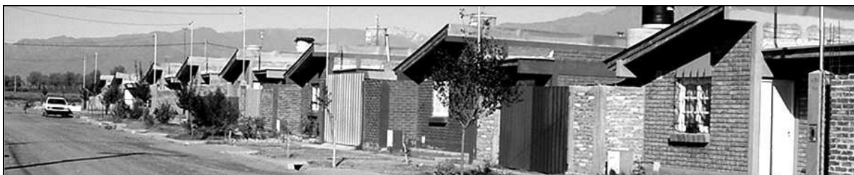
Figura 5. Viviendas alineadas a igual retiro de línea municipal. Imagen de uniformidad inalterable.
