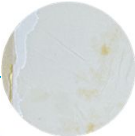
Dobles y desprendimientos
