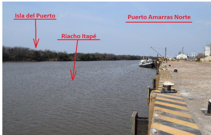
Sector de amarre Norte del puerto. Vista hacia el sur
