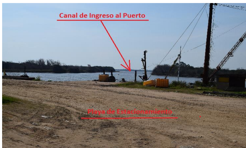
Continuación hacia sur del sector de Amarre Norte, hay una playa de estacionamiento de vehículos de carga.
