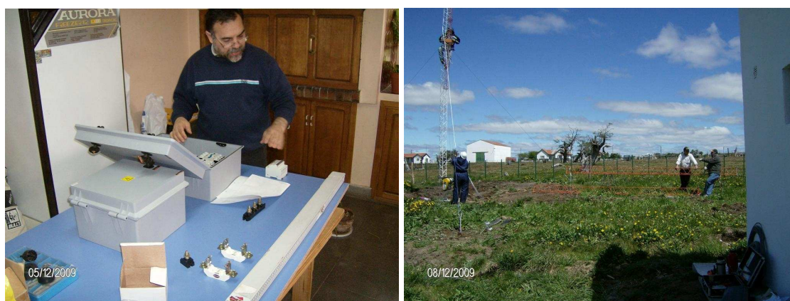
Figuras 3 (izq) – Armado de Tableros y ensayos y (der) Instalación de Torres y molinos 8-12-09
