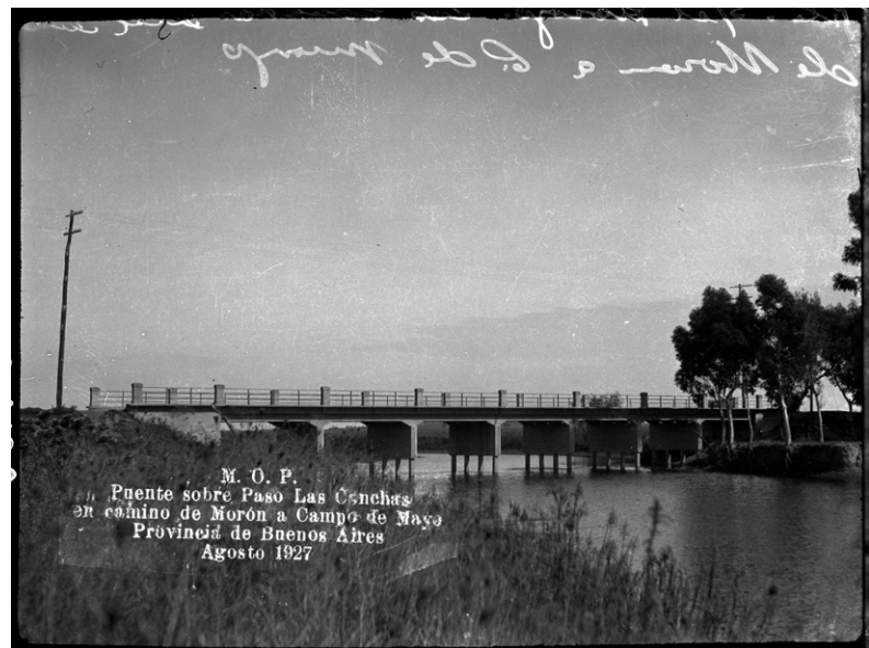
FIGURA 2 | Puente sobre el río Reconquista en el camino entre Morón y Campo de Mayo, 1927 (documento perteneciente al archivo del Centro de Documentación e Investigación de la Arquitectura Pública —CeDIAP— del CDI del Ministerio de Hacienda y Finanzas Públicas).1998).
