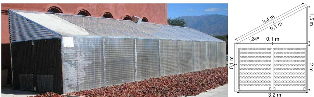
Figura 2. Caras norte y este de la cámara de secado. Se aprecian los colectores solares en techo y pared, y la puerta de entrada de producto fresco. Esquema de sección de la cámara de secado.
