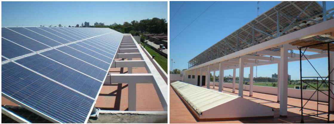
Figura 11: Pérgola FV de 17 kW<sub>p</sub> en la Facultad de Informática de la UNLP.
