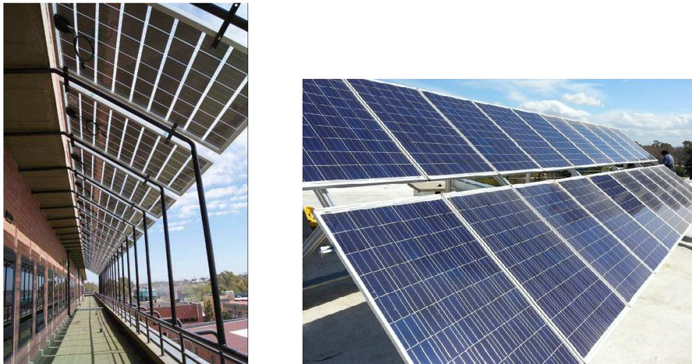
Figura 6.: Sistemas FV instalados en el edificio TANDAR (CAC): (i) pérgola FV con 23 módulos de 215 W<sub>p</sub>, ubicada en el tercer piso del edificio (izquierda); (ii) 20 módulos FV de 240 W<sub>p</sub>, ubicados en la terraza (derecha).
