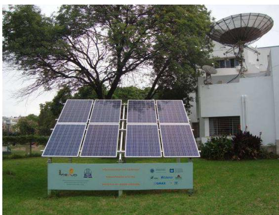
*Figura 5: Sistema FV de 1,92 kW<sub>p</sub> instalado en la Asociación Argentina Amigos de la Astronomía.*
