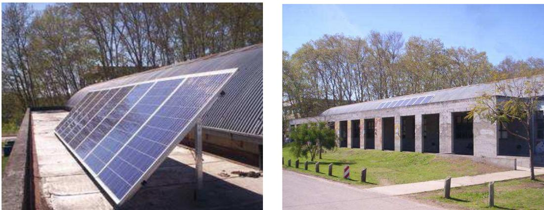
Figura 12: Sistema FV de 1,92 kW<sub>p</sub> instalado en la UNLu.
