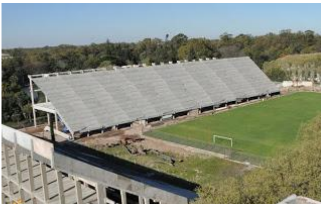
Estadio en construcción "Tierra de Campeones"
