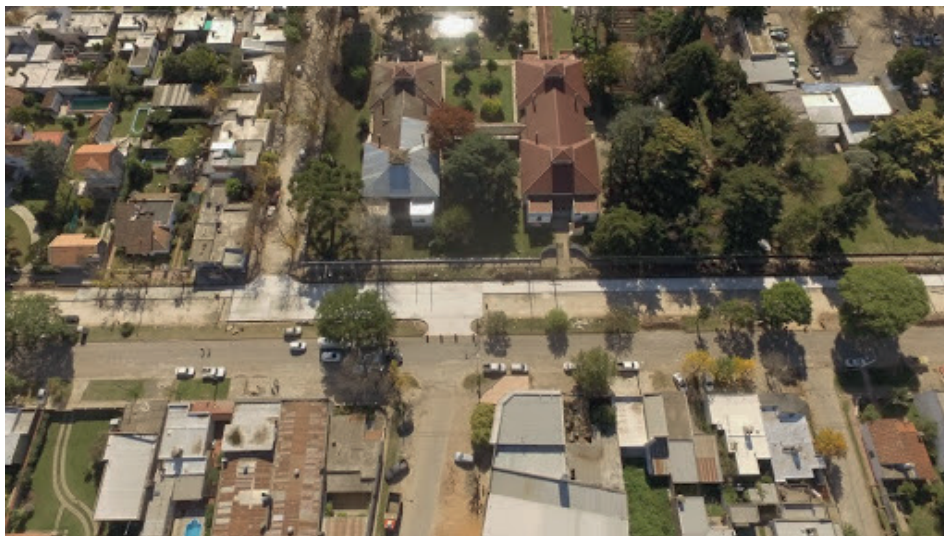
Imágenes de la obra de repavimentación de avenida 2 Fuente: Dirección de Prensa de la Municipalidad de Mercedes
