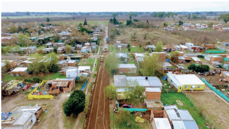
Imágenes de la obra en calle 61
