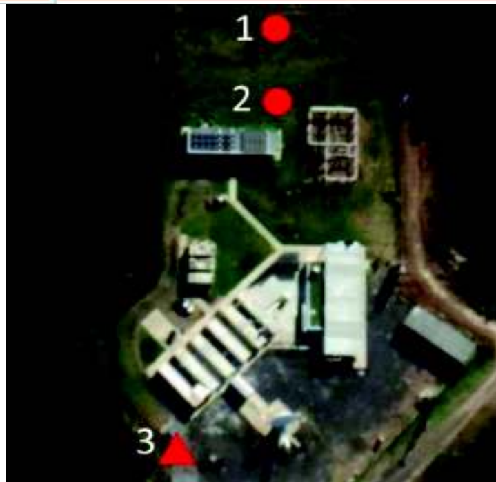
Figura 3.- Campo de ensayo utilizado en AGGO.
