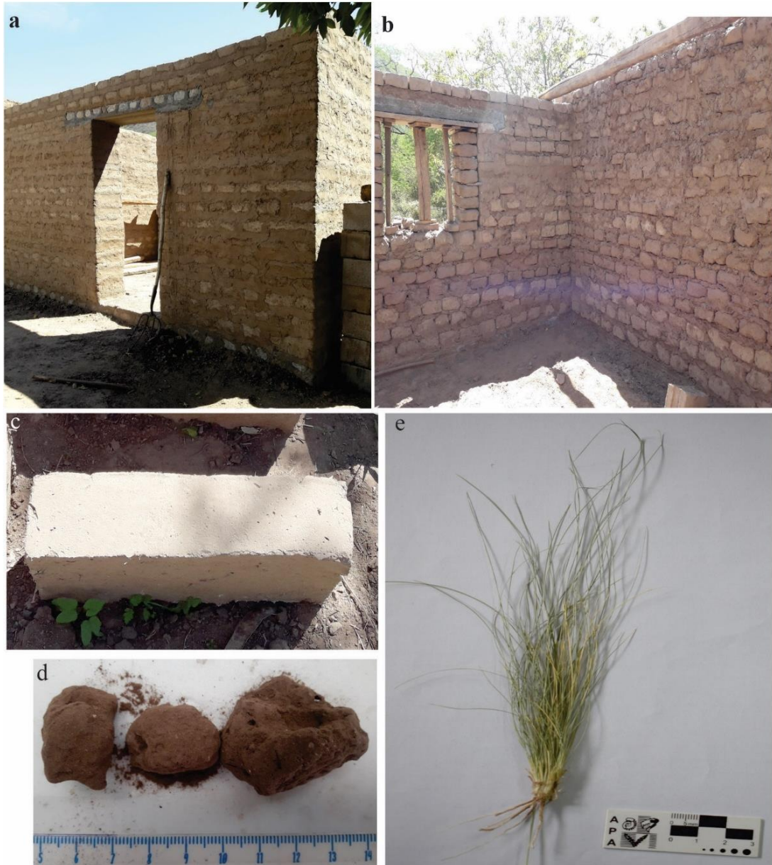
Figura 9.3. Material etnobotánico de El Shincal. a-b. construcción de muros con adobes reutilizados; c. ladrillo de adobe; d. muestra de adobe analizada; e. material vegetal de referencia denominado “paja del cerro”. Fotografía de la autora.
