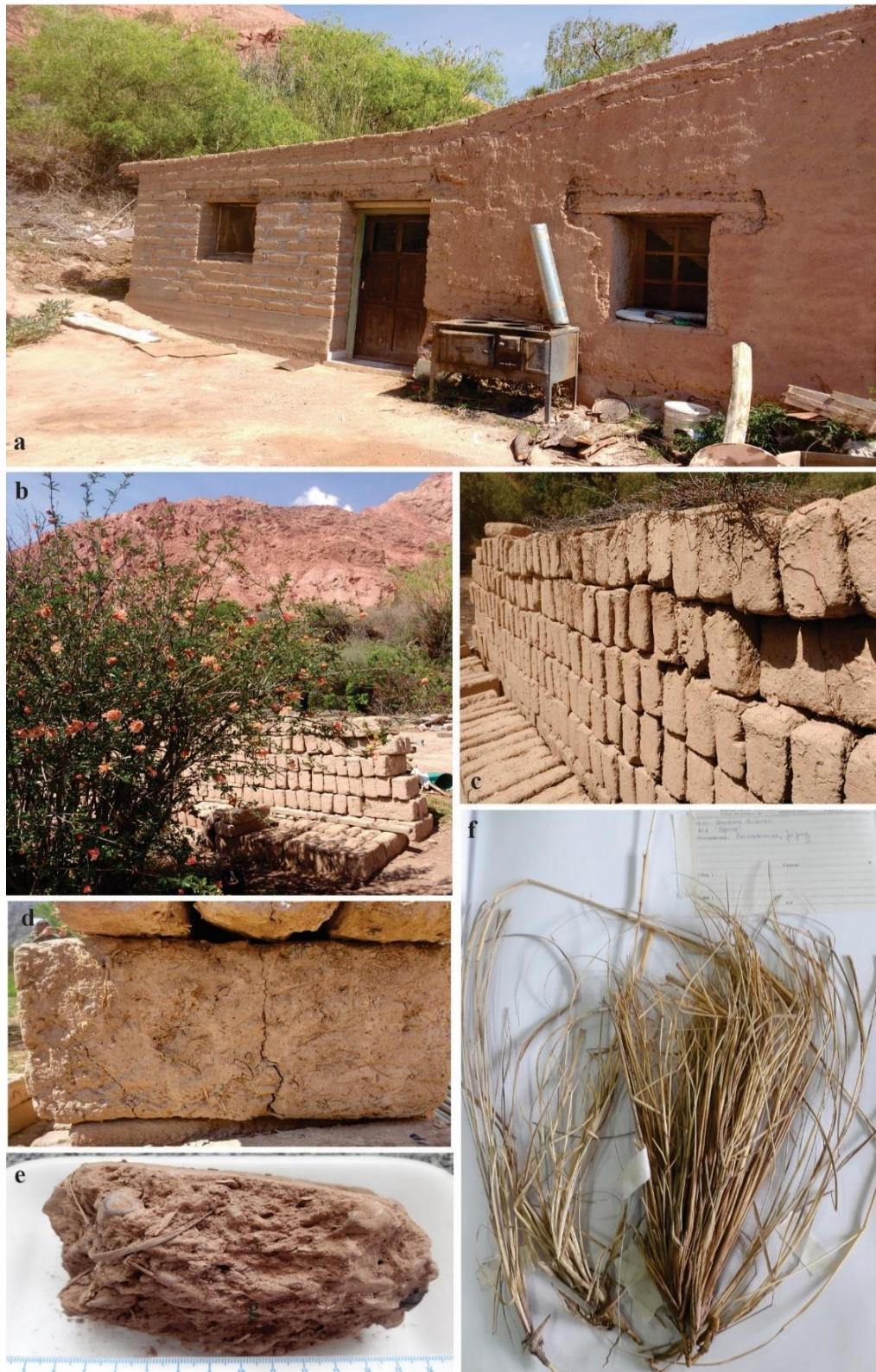
Figura 9.4. Material etnobotánico de Purmamarca. a. construcción en adobe (Foto: Capparelli A.); b-c. acopio de ladrillos de adobe (Foto: Capparelli A.); d. adobe en el que se observan restos de fibras (Foto: Capparelli A.); e. muestra de adobe analizada; f. material vegetal de referencia denominado “espuro”.
