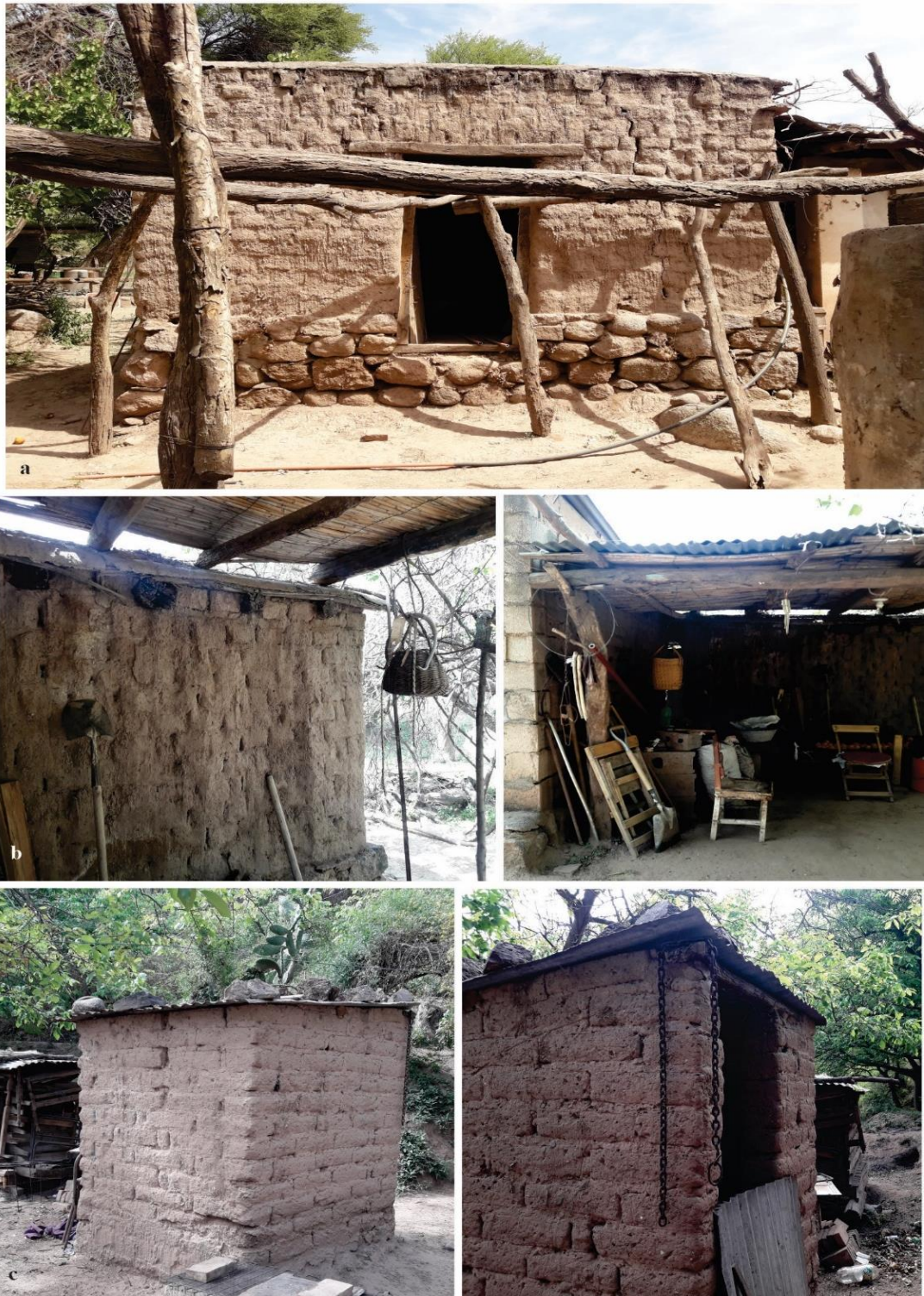
Figura 9.5. Construcciones en adobe que pertenecían a los entrevistados en El Shincal. a. vivienda doméstica, b. sector con paredes de adobe y techo de madera y cañas (izquierda), a su vez el techo está recubierto con chapas de metal (derecha); c. habitación de almacenamiento con paredes de adobe y techo de chapa.
