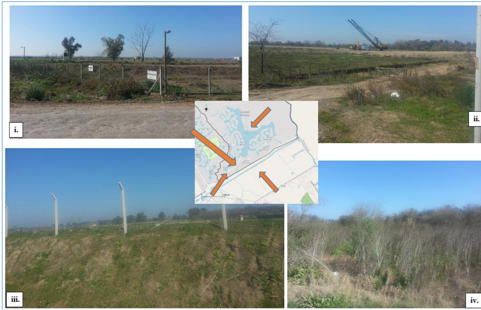
Figura 5.5. Imágenes fotográficas del proceso de construcción de los barrios de Puertos
