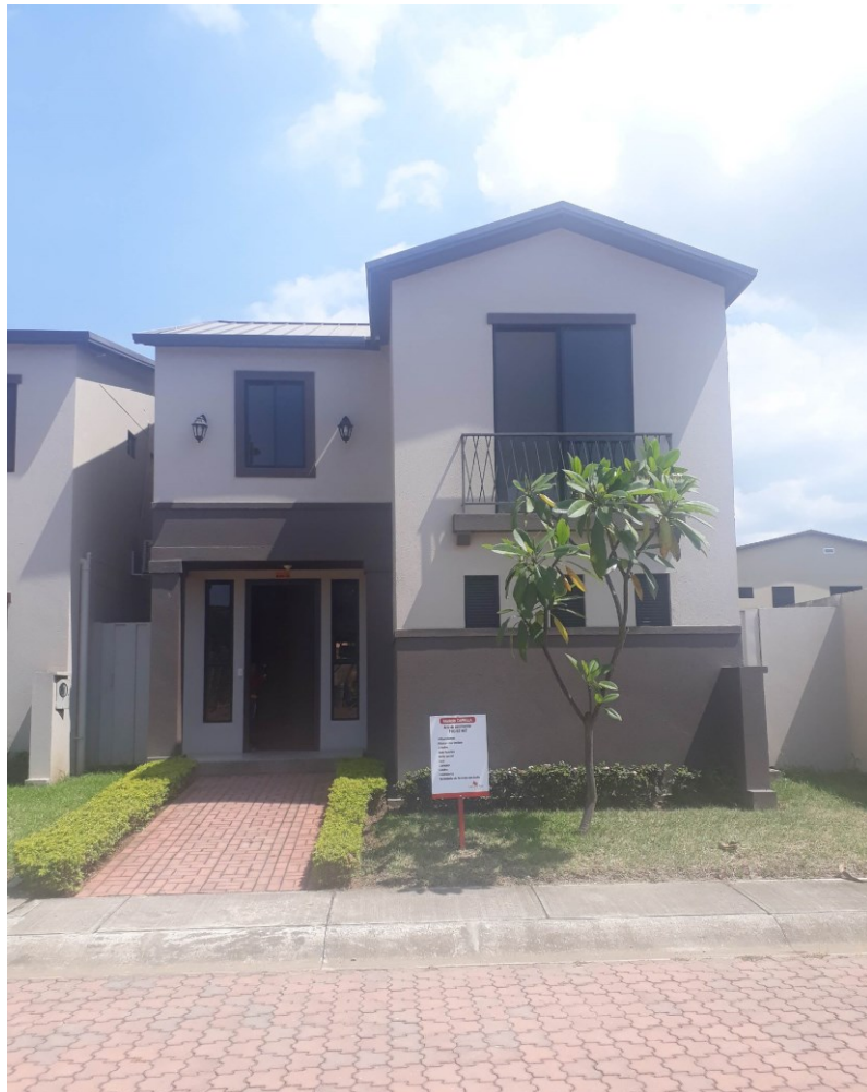
Figura 146. Viviendas de etapas recientemente construidas Fotografía tomada por la autora
