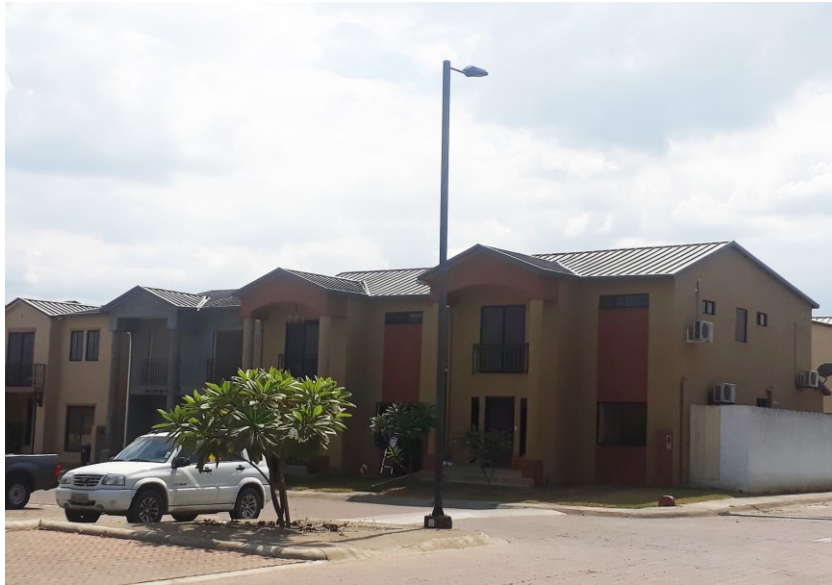
Figura 145. Viviendas de etapas recientemente construidas Fotografía tomada por la autora
