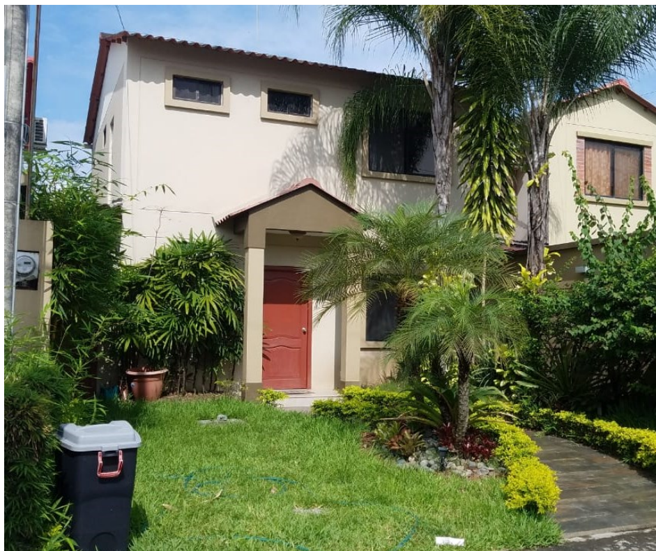
Figura 55. Fotografía fachada frontal
