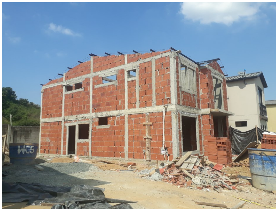
Figura 144. Vivienda en construcción Fotografía tomada por la autora
