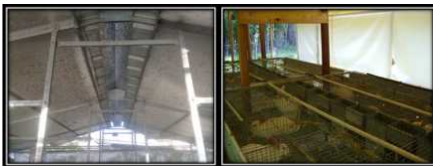
Figura 17: Izquierda, galpón con apertura cenital. Derecha, Cortinas laterales para la ventilación.
