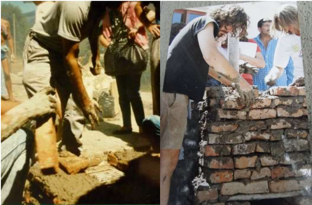
[Figuras 76 (Izq.)] Construcción del horno mapuche desde su base. [Figura 77 (Der.)] Vista frontal de la construcción en la Cooperativa de El Bolsón
