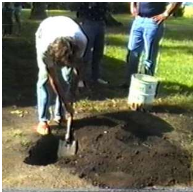
[Figura 91] Delimitación del terreno y socavado del pozo La delimitación del perímetro con una pala para lograr la forma de huso, dirigido según los vientos.
