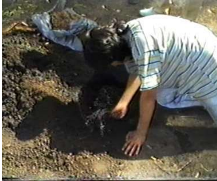
[Figura 95] Se va perfilando las paredes primero con agua. El autor alisa e hidrata la superficie del horno para poder agregar más pastón y que pueda adherirse en ella.
