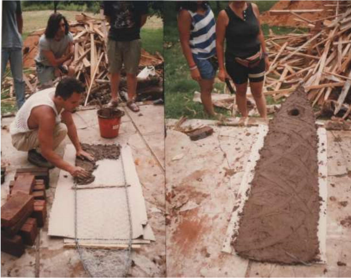
[Figuras 32 (Izq.)] Proceso de armado: montaje de los planos del obelisco sobre una plataforma de cemento cubierta con cartón corrugado. [Figura 33 (Der.)] Sobre alambrado se coloca los pastones de la mezcla de arcilla.
