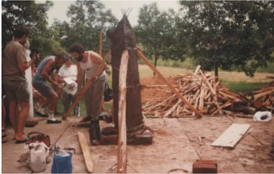
[Figura 36] Contexto de trabajo. G. Mañè sujeta y apuntala el proyecto con maderas porque la mampostería está recién hecha con pastón fresco.
