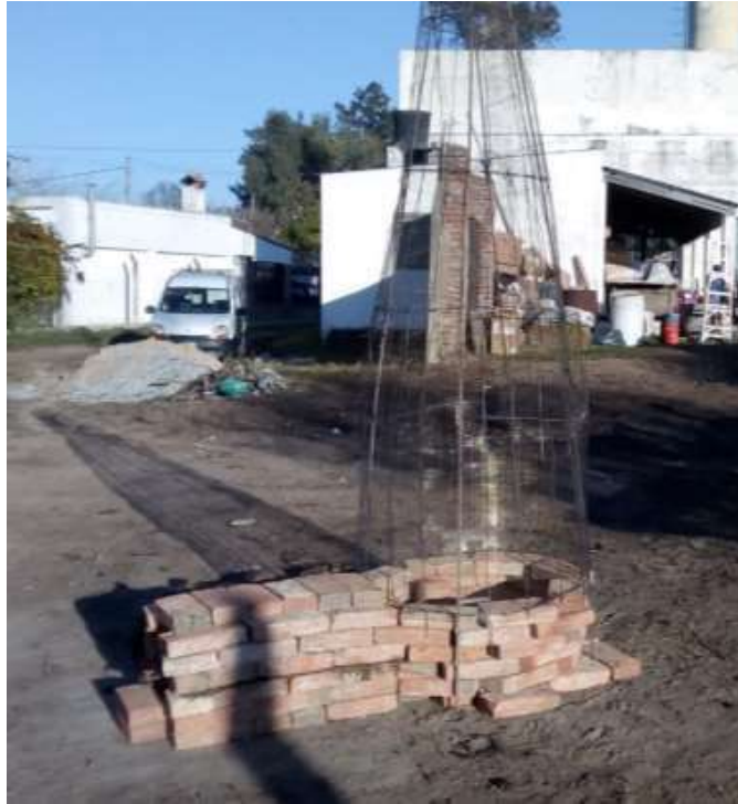
[Figuras 47] Armado de la estructura metálica
