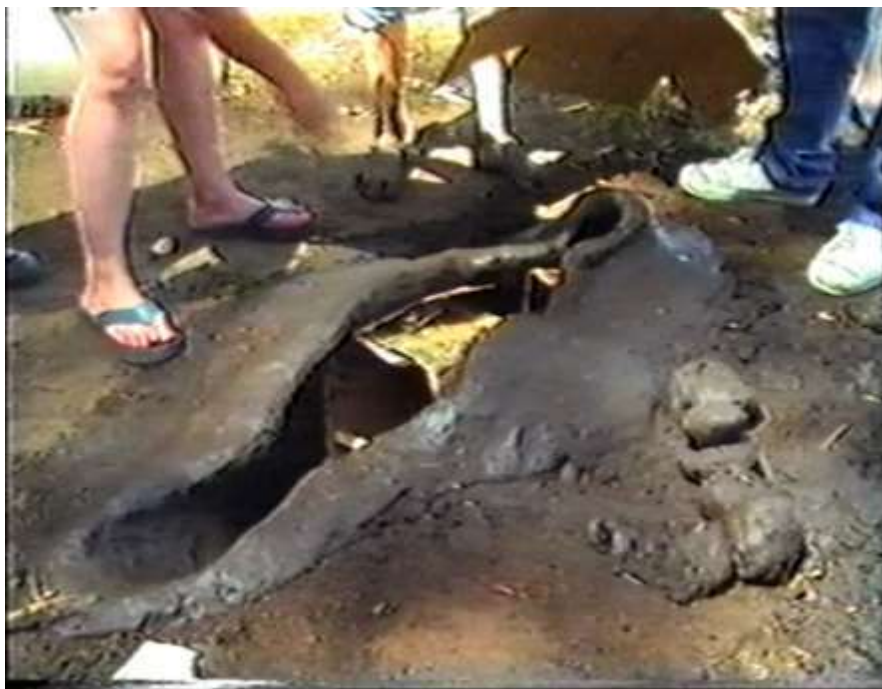
[Figura 99] Una vez concluido el armado se deja secar por completo aproximadamente entre 5 a 7 días.
