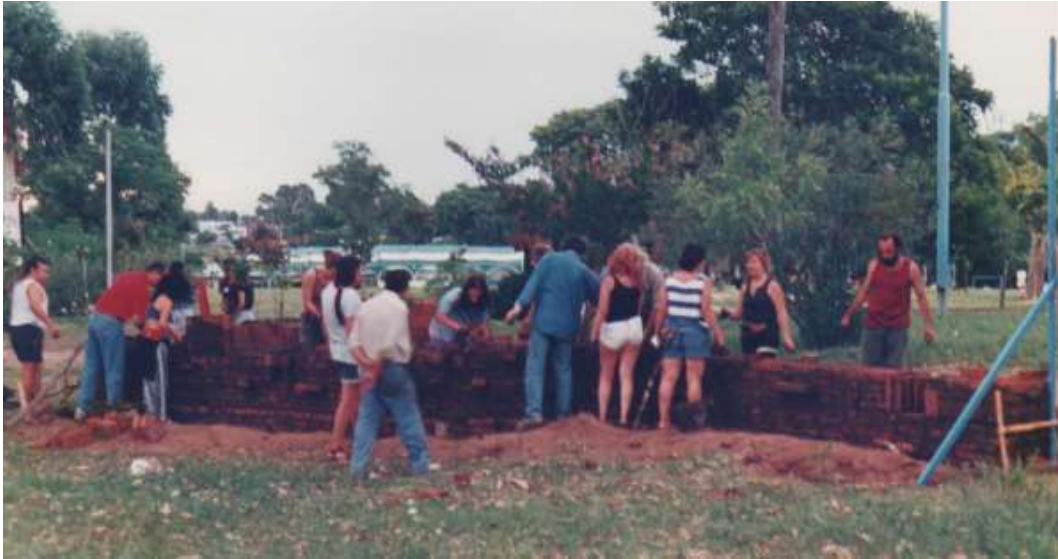
[Figura 14] Las bases se emplazan sobre el terreno con ladrillos comunes y pastón.
