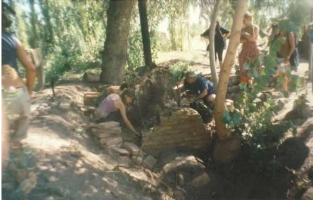
[Figura 109] Desarmando el horno y rescate de las piezas entre las cenizas.
