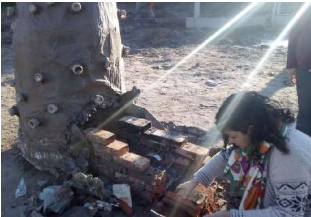
[Figura 50] La inclusión del cenicero y boca de carga con ladrillos y hierros en un primer plano.
