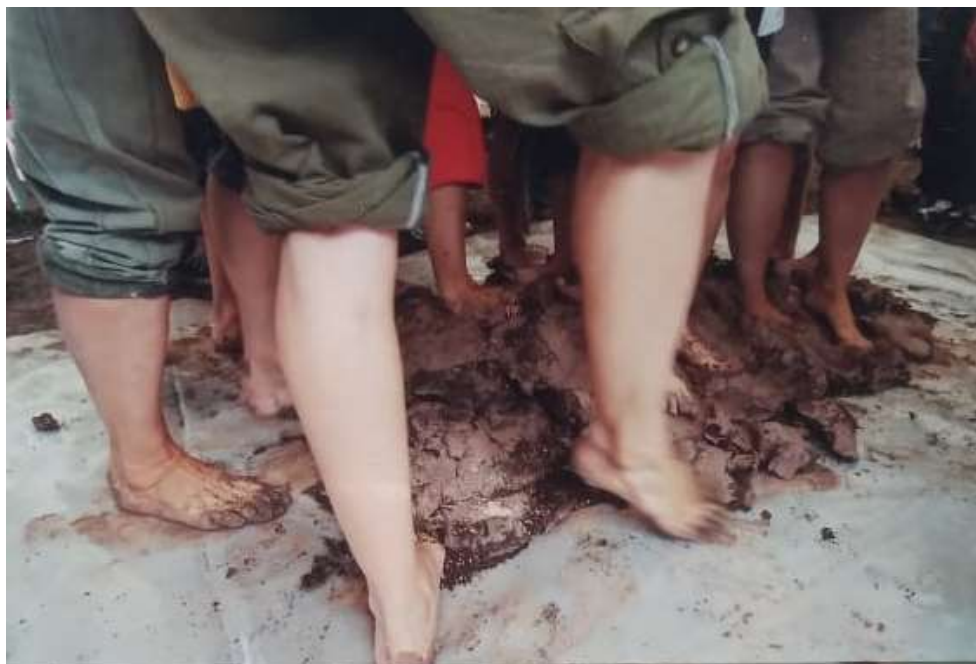
[Figura 115] Detalle del método comunitario de mezclar e integrar todos los elementos para hacer la pasta cerámica.
