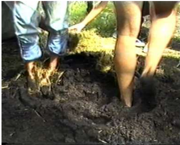
[Figura 94] Se pisa para otorgar plasticidad a la componenda, integrando muy bien los materiales.
