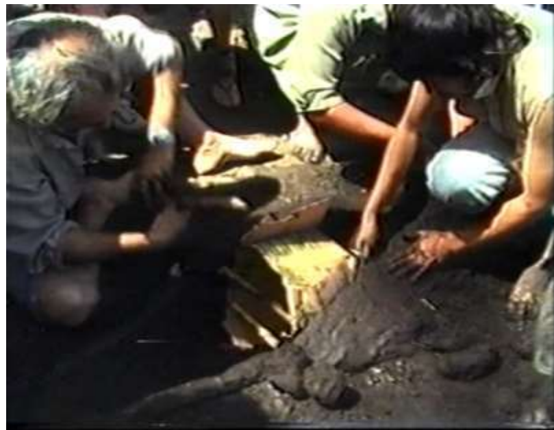
[Figura 98] Momento de estructurar las paredes con elementos disponibles en el predio y así sostenerlas para montar el techo del horno con una cimbra artesanal de cartón.
