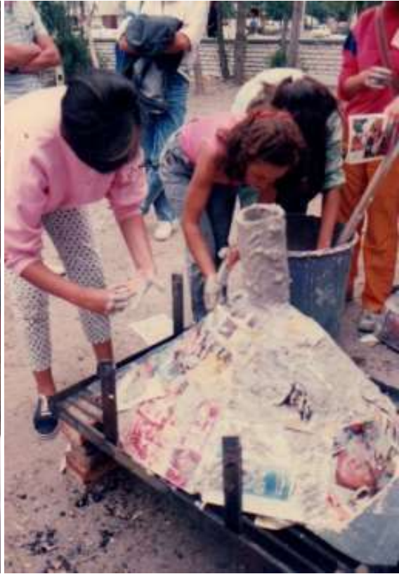
[Figura 10 (Izq.)] y [Figura 11 (Der.)] Armado del horno con sucesivas capas.
