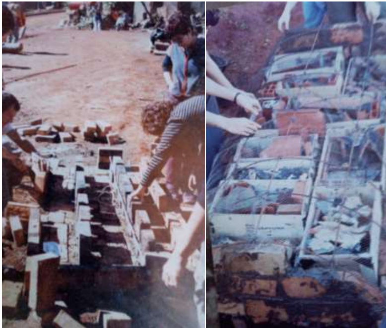
[Figura 41 (Izq.)] Soportes de ladrillos refractarios y parrillas de hierro para estructura y montaje.
