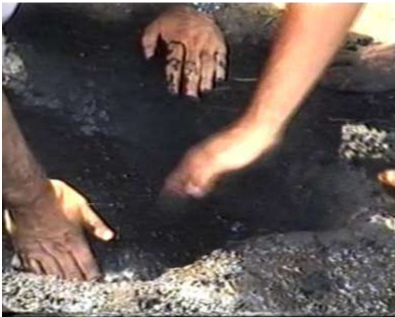
[Figura 96] Se rellena con el pastón levantando nuevas paredes adentro del horno para otorgarle estructura y refractariedad.
