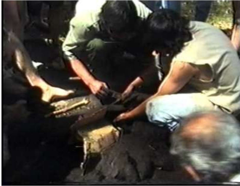
[Figura 97] Las paredes del horno se compactan muy bien dando golpes con las manos.
