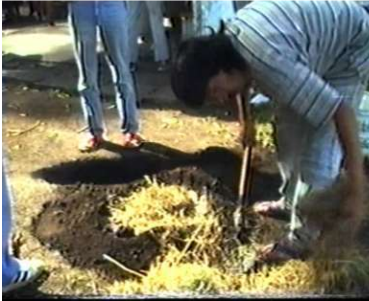
[Figura 93] Incorporación de paja y arena para otorgarle estructura.
