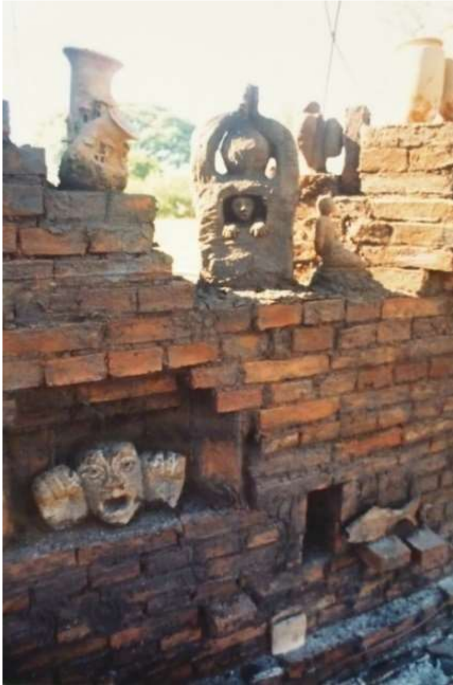
[Figura 17] El buen tiempo facilitó el secado de un costado. La pared expuesta a la sombra debió templarse durante toda la noche porque ladrillos, pastón y piezas conservaron la humedad.
