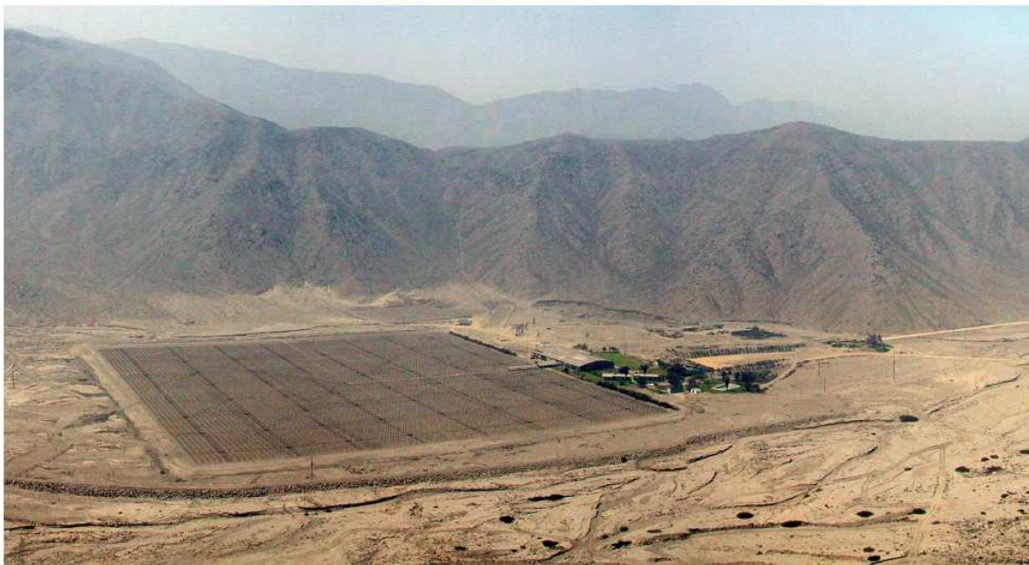
Figura 3.13: Agrupación de antenas del radar ISR Jicamarca [59].
