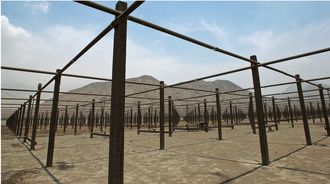
Figura 5.1: Agrupación de antenas principal del radar del Radio Observatorio de Jicamarca [97]. Es la más grande entre los radares de dispersión incoherente en el mundo, consiste en un arreglo cuadrado de 300 m × 300 m y está conformada por 18.432 antenas dipolos cruzados.
