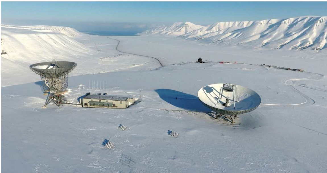
Figura 3.1: Instalaciones del Radar EISCAT Svalvard [45]. Se pueden apreciar las antenas parabólicas reflectoras que emplean el sistema Cassegrain.
