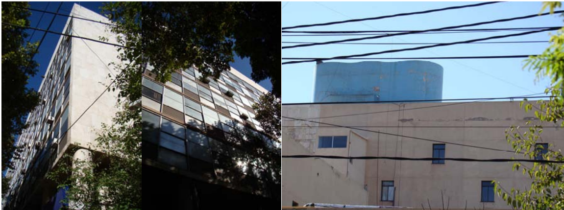
Imagen IV.57 Fachada Principal Correo de Mendoza. Autores: arqs. Bianchi y Vidal Fuente: C. Eliggi, 2009
