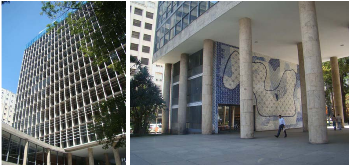
Imagen IV.6 MES, Parasoles en fachada . Río de Janeiro. Foto: C. Eliggi, 2011 Imagen IV.7 MES, Escala monumental . Río de Janeiro. Foto: C. Eliggi, 2011
