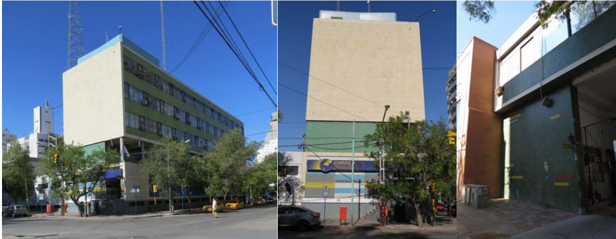
Imagen IV.122 Fachada Principal correo de Neuquén. Foto: M. Henning, 2017. Imagen IV.123 Fachada con murales abstractos. Correo de Neuquén. Foto: M. Henning, 2017. Imagen IV.124 Vivienda del Jefe murales abstractos. Correo de Neuquén. Foto: M. Henning, 2017.
