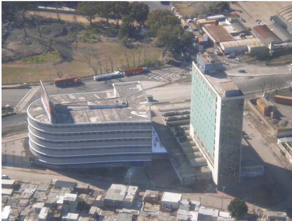
Imagen III.45 Croquis del Edificio Movimiento, Puerto Nuevo de la Ciudad de Buenos Aires. Ilustración: Rinaldo Miscione. Fuente: Revista Nuestra Arquitectura n°328 ago, 1958
