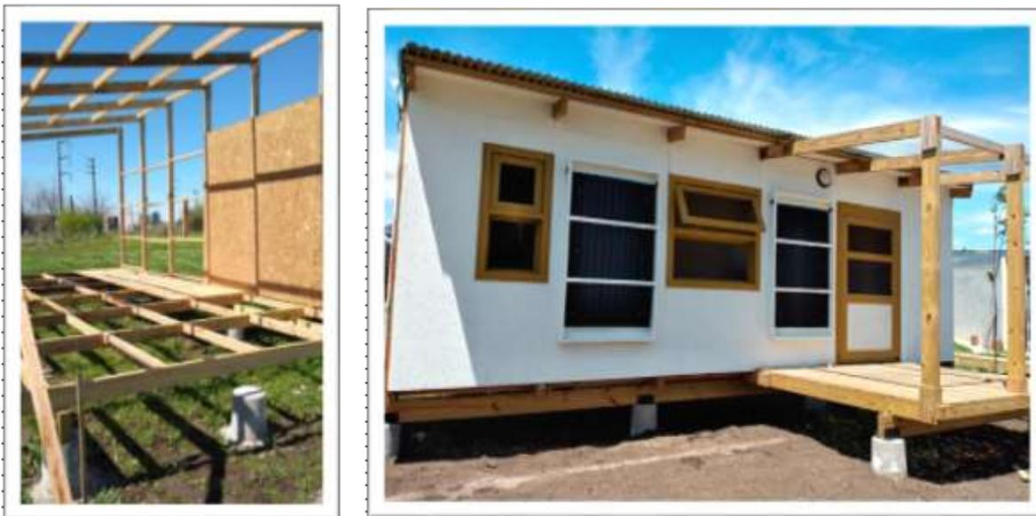
*Foto 1 (a la izquierda): Proceso de construcción de la SHE. Foto 2 (a la derecha): Diseño de la Solución Habitacional de Emergencia terminada. Fuente: <https://ctm.agro.unlp.edu.ar/content/prototipo-habitacional-de-emergencia>*
