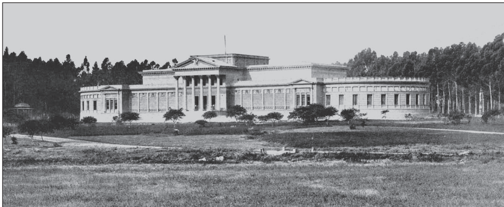
4. Museo de La Plata hacia finales del 1900. Nótese que aún no se habían colocado las ventanas del nivel cero, obra que data de 1911. Foto: Archivo Fotográfico Ministerio de Infraestructura de la Pcia. de Bs. As.
