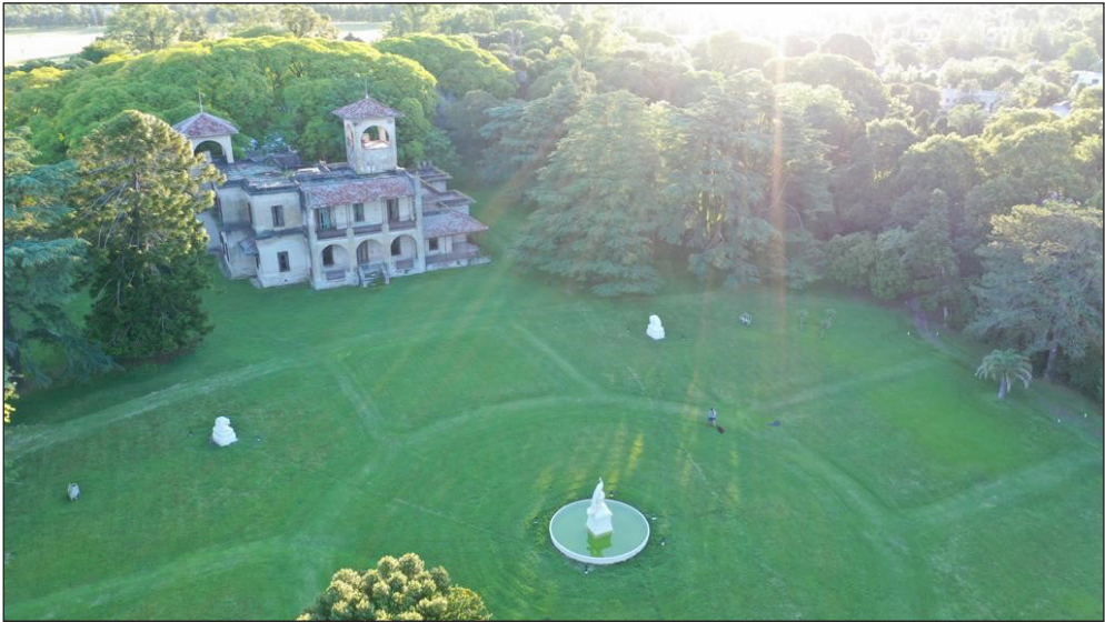
8. Vista general de la restauración desde un Dron, diseño de Gastón Welter 1925.
