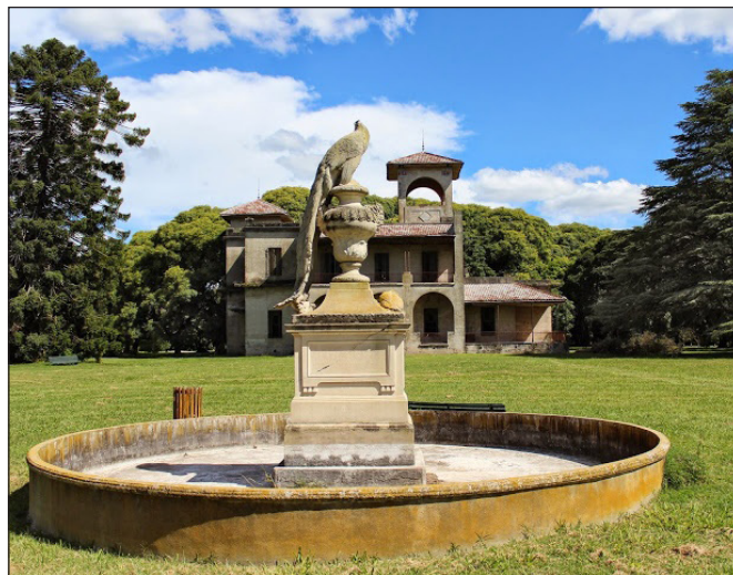
6. Estado del Pavo Real y Pichón antes de la restauración 2018. Foto Autor.
