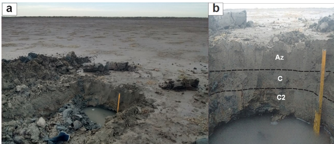
Figura 4.28. a. Marisma baja en Planicie mareal arenosa. b. Calicata de MSB-48.
