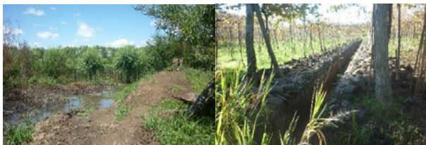
Figura 3: Izq.; terraplén, der.: zanjillo. Fuente: fotografías propias.
