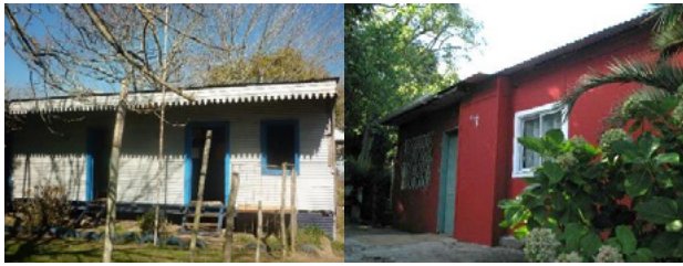
Figura 2: Izq.: vivienda elevada, der.: vivienda construida a nivel del suelo. Fuente: fotografías propias.
