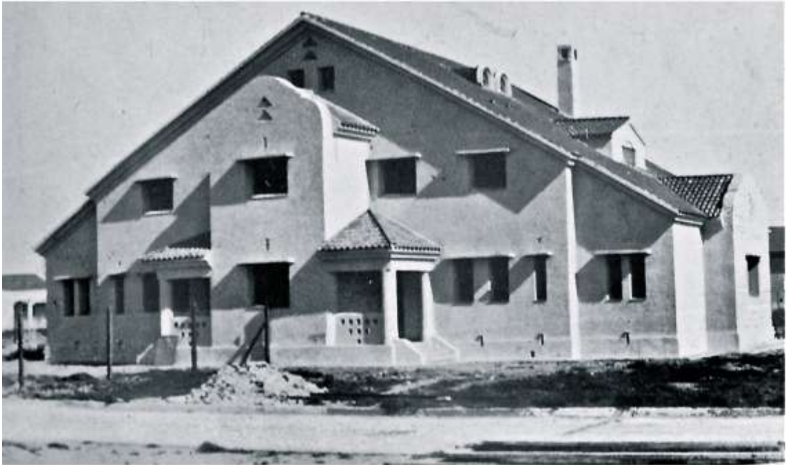
Foto pabellón de clínica Colonia de Crónicos en General Rodríguez (1939). Fuente: Revista Obras Públicas y Privadas, n° 12, 1939.
