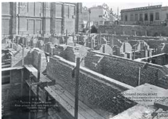
Segunda sección Aduana en Rosario en construcción (1929). Fuente: CEDIAP.
