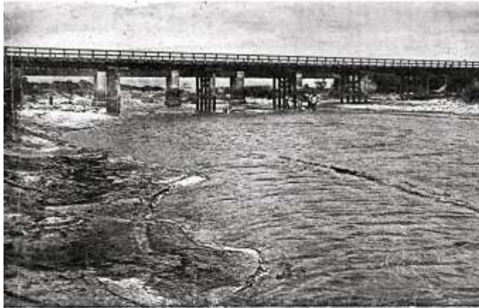
PUENTE DE MADRERA, de 70 metros de luz, sobre el arroyo El Taba, en el cantón de Vera y Bonaquiere.
