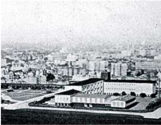
Maqueta de una escuela de artes y oficios tipo capital (1939). Fuente: Revista de Arquitectura , nº 235, julio de 1940.
