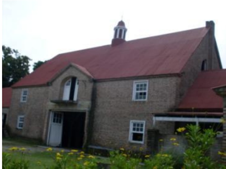
Fig 5.9- Frente del centro de la construcción en forma de "U" en la reserva "El Destino", se observa la parte central de dos pisos.
