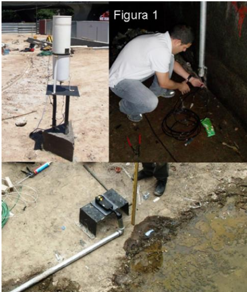
Fotografía superior izquierda, pluviógrafo en Niceto Vega; superior derecha, limnógrafo en Arroyo Madonado, abajo, caudalímetro en canal de descarga.
