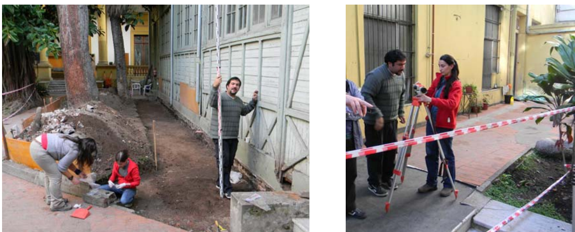
Figura 4. Relevamiento topográfico previo al cavado de la zanja
