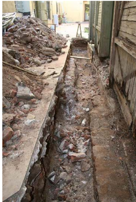
Figura 3. Vistas del cantero en diferentes momentos de la excavación de la zanja
