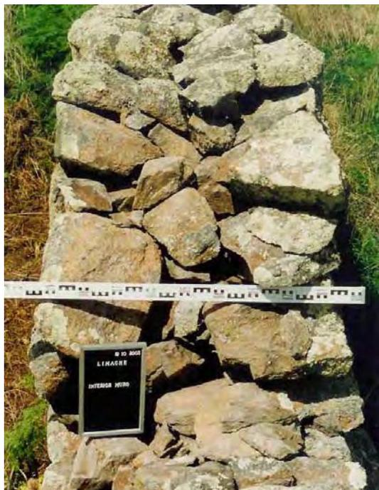
**Figura 7.47** Construcción de piedra de estancia Limache. Abajo: esquina redondeada de la estructura B con orificio de desagüe. Izquierda: vista del interior del muro.
