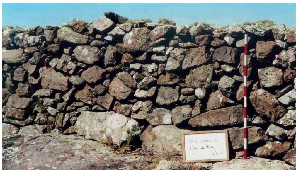
Figura 7.36 Muros de piedra de las Sierras de Azul con distintas formas de terminación.
