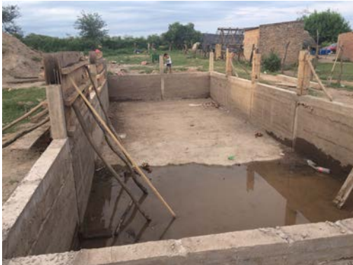
Figura 3. Cisterna en construcción.
