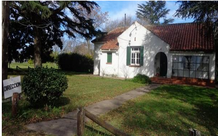
Figura 15. Estación Julio Hirschhorn
