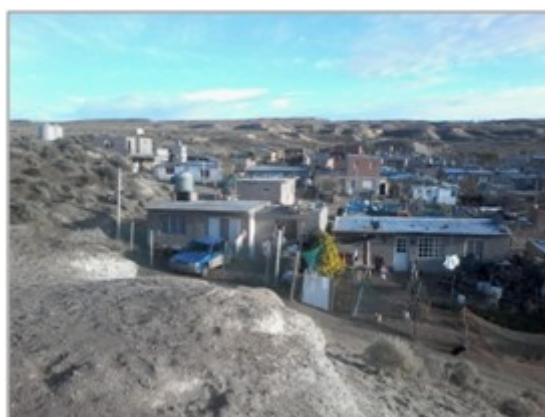
Figura 3 . Viviendas sobre laderas (Alta Tensión)
