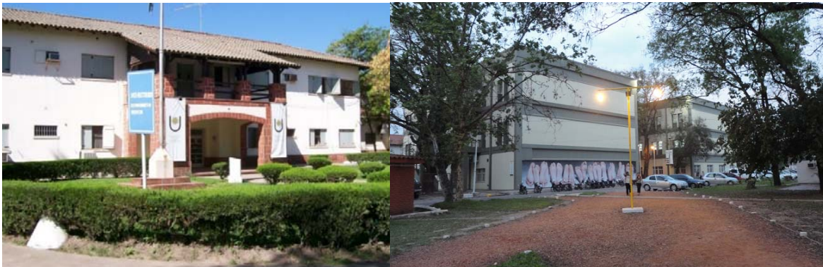
Fot. 1 y 2. A la izquierda, edificio que data de la década del 50 y aún conserva sus características tecnológicas constructivas originales, a la derecha, ampliación terminada en el año 2001.
