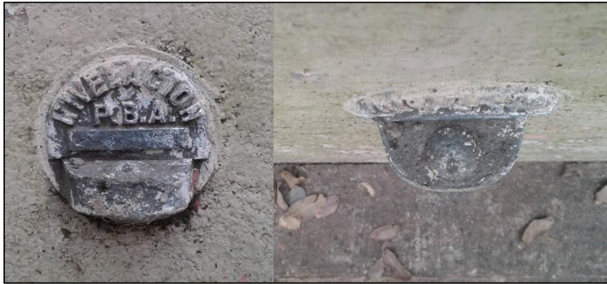
Figura 3-5: Punto Fijo ubicado en la cara SE del edificio de Química. Se trata de un punto de Nivelación de la Provincia de Buenos Aires. Esta nivelación se encuentra referida al 0 del IGN, por lo tanto, dicho punto posee cota IGN.
