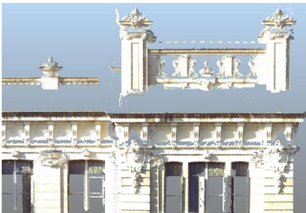
Figura 3-34: Zoom de la zona superior-derecha de la nube de puntos resultante de la fachada de rumbo SO del Colegio Nacional.
