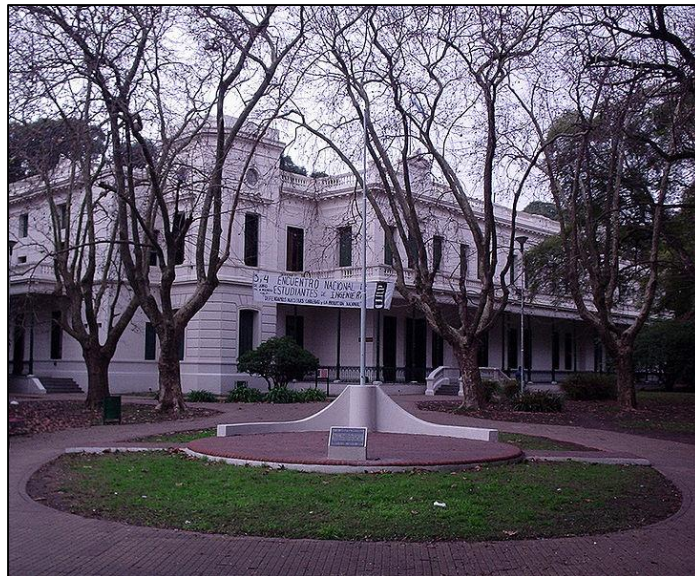
Figura 1-2: Edificio Central de la Facultad de Ingeniería de la UNLP.
