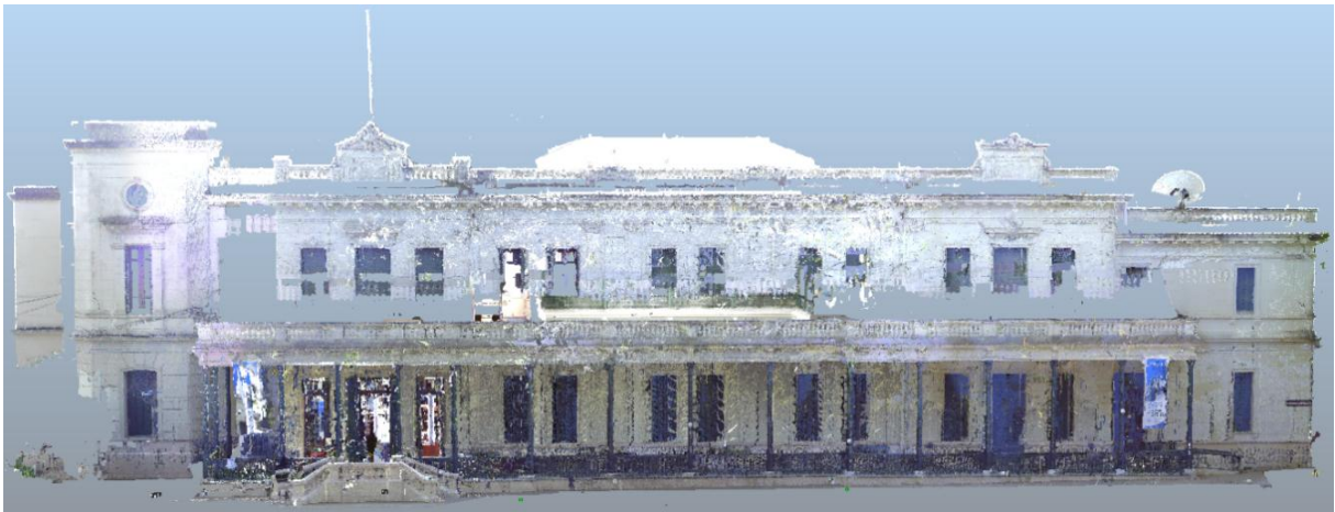
Figura 3-27: Modelo Digital 3D georreferenciado y texturizado de la fachada de rumbo SO del Edificio Central de la Facultad de Ingeniería.
