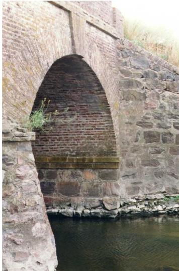
Fig. 7.b. Detalle del puente de Azul mostrando revestimiento de los estribos
