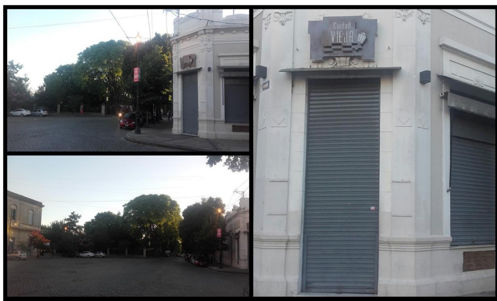
Figura N°17: Fotografías propias que muestran el bar Ciudad Vieja . La foto de la derecha muestra la puerta de entrada del bar, mientras que la imagen de arriba a la izquierda, desde un plano más alejado, ilustra la fachada del bar emplazado en la intersección de las calles 17 y 71. La última imagen (abajo a la izquierda) permite ver en esa misma esquina frente al bar un edificio en donde se emplaza el Centro Cultural Estación Provincial .
