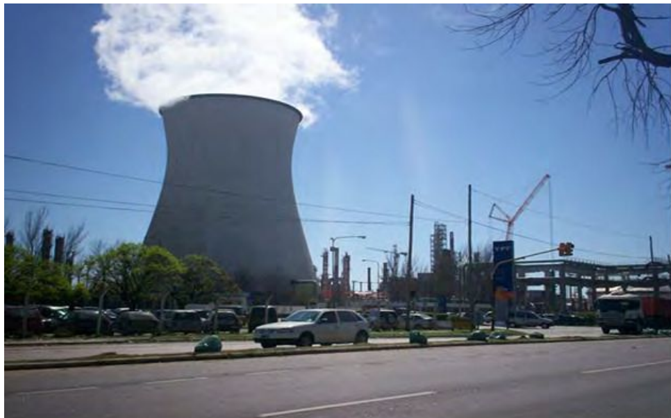
Figura 97. Foto actual de la torre de refrigeración de la Petroquímica
