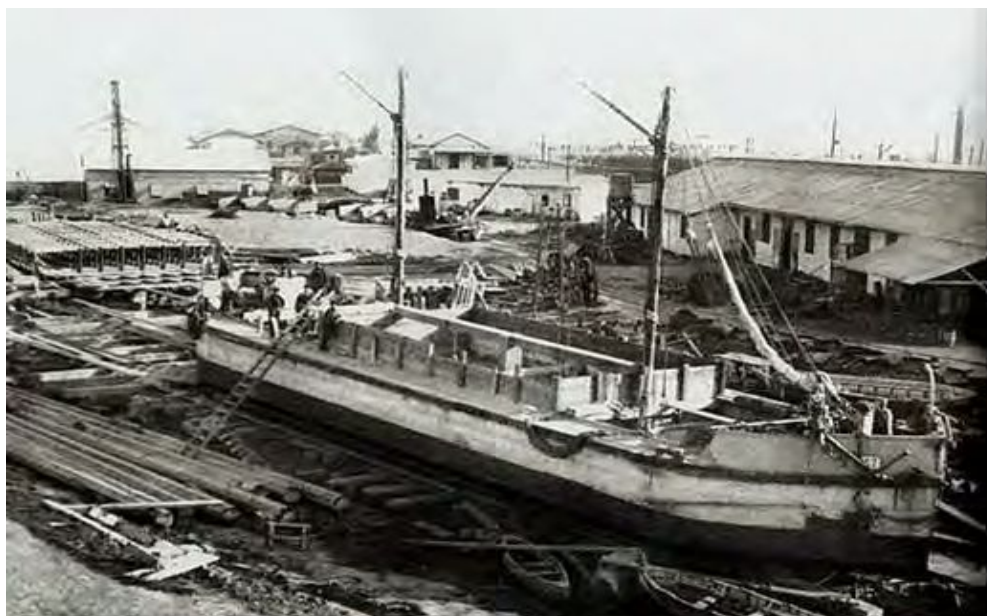
Figura 13. Trabajos en el Astillero Rio Santiago
