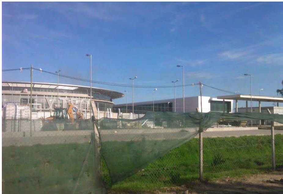
Figura 105. YTEC CONICET, obra en construcción
