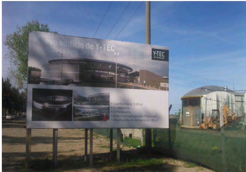
Figura 104. YTEC CONICET, inicios de la obra
