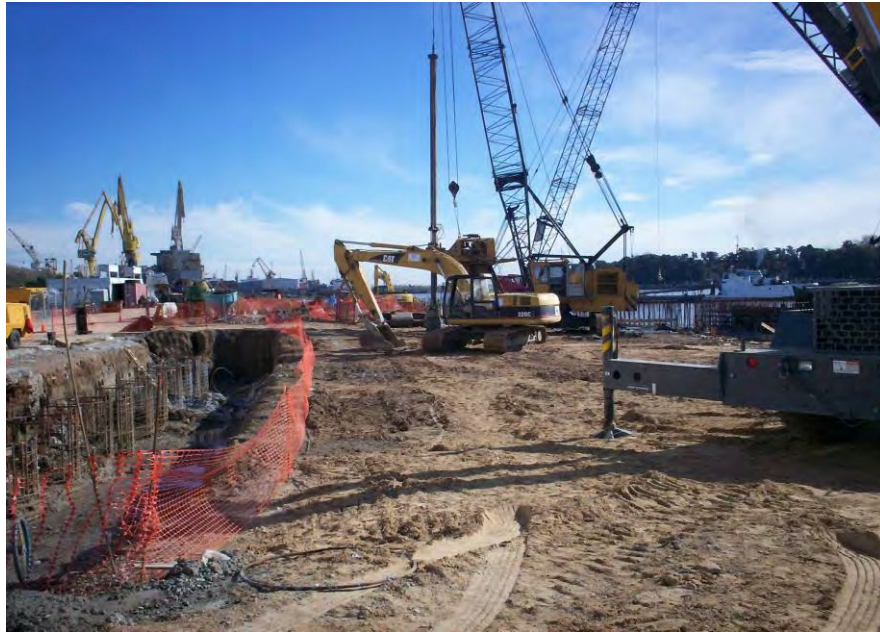
Figura 107. Obras de relleno para TEC Plata
