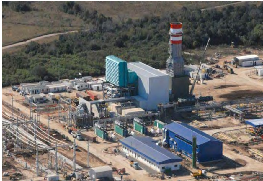
Figura 108. Central Termoelectrica de Ensenada de Barragán
