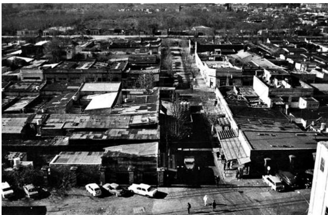
Figura 21. Vista área de Calle Nueva York de Berisso
