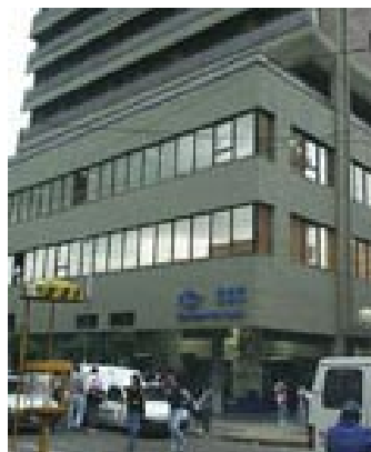
Figura 9: Edificio frentes Norte y Oeste
