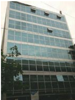
Figura 1: Edificio con mayor superficie vidriada (aproximadamente 90% de la fachada)
