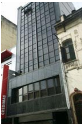
Figura 6: Edificio frente Norte
