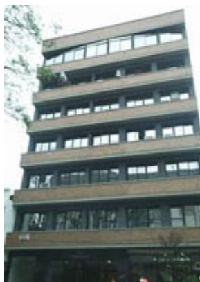
Figura 8: Edificio frente Este
