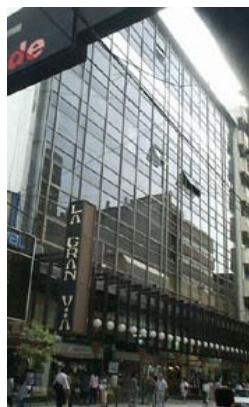
Figura 7: Edificio frente Sur
