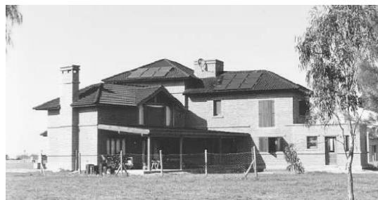
Figura 3: Vista NO de la instalación completa, con los 15m 2 orientados al Norte con una inclinación de 30°
