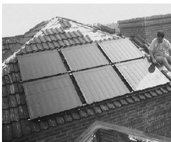
Figura 1: Presentación de los colectores durante el montaje
