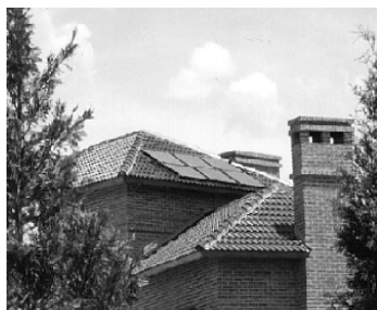
Figura 2: Vista NE de parte de los colectores instalados
